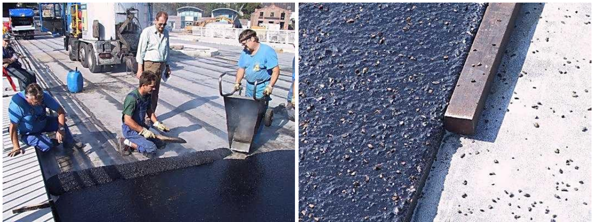
Figur 1 Läggnig av gjutasfalt på bro med handredskap (t.v.) och nylagd gjutasfalt med stenbeströdd yta (t.h.).
